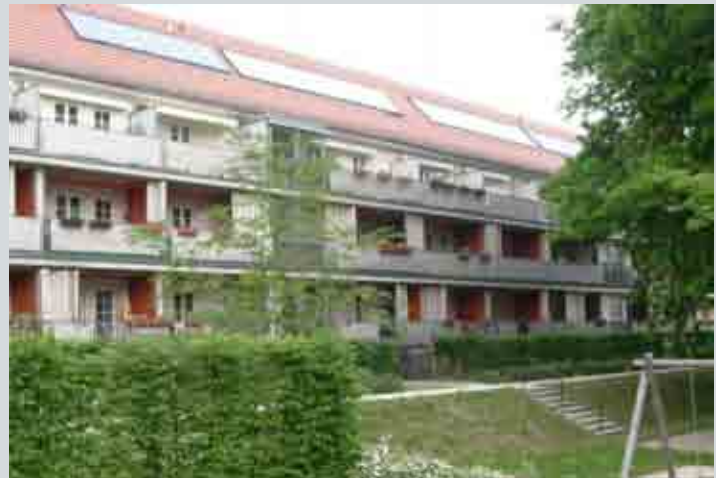
Projekt Solarenergie: Sonnenkollektoren auf den Dächern der Laubergaster Höfe in Dresden
